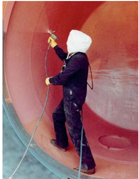
Fig. 6: les résines époxy sont une cause fréquente d'allergies cutanées. Lors de l'utilisation sur de grandes surfaces et surtout lors d'applications au pistolet, la présence de vapeurs et d'aérosols dans l'air ambiant peut provoquer des eczémas. Il est donc nécessaire de protéger la peau dans sa totalité.
